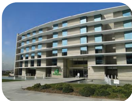
Blindex Acústico Hotel Holiday Inn Express, Aeropuerto de Santiago. Arquitecto: Ruiz Tagle Vicuña Arq. Atenuación: 50dB.
